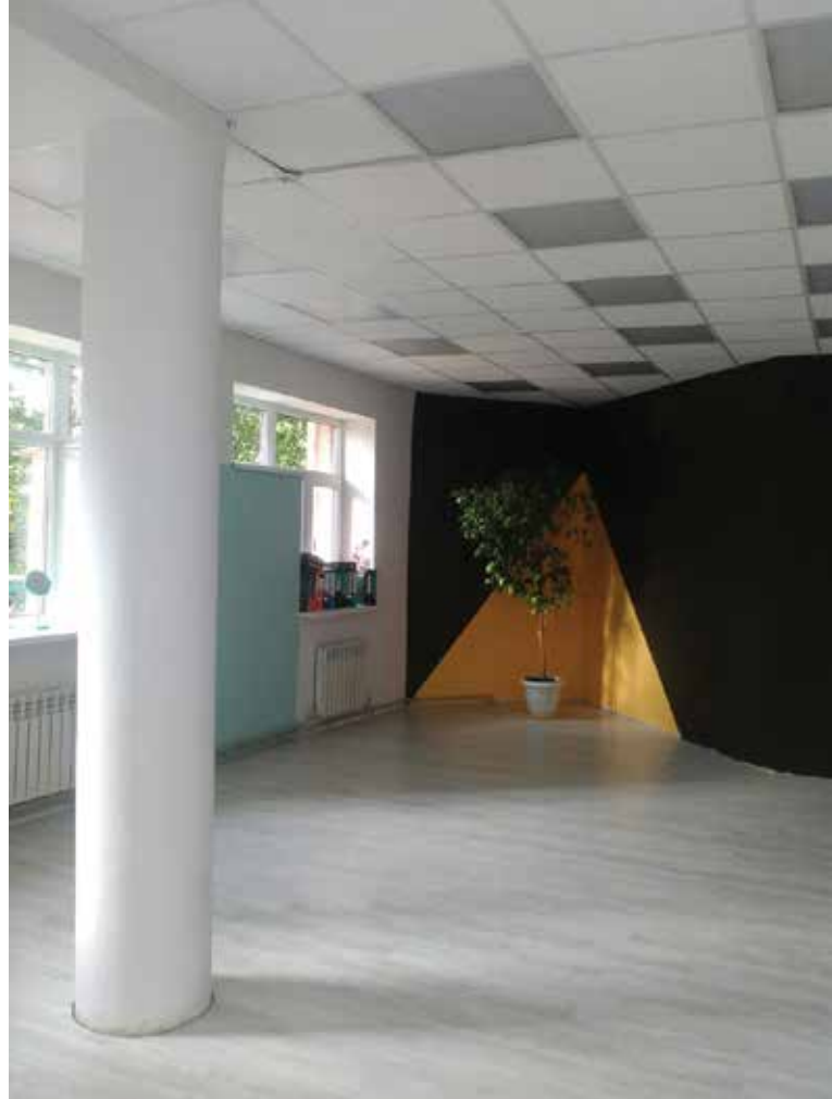
ПОМЕЩЕНИЕ БИБЛИОТЕКИ-ФИЛИАЛА № 20 ВО ВРЕМЯ РЕМОНТА
